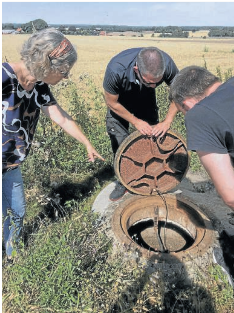
Inspektion af en pumpebrønd for skader på betonen som følge af svovlbrinte i spildevandet.
